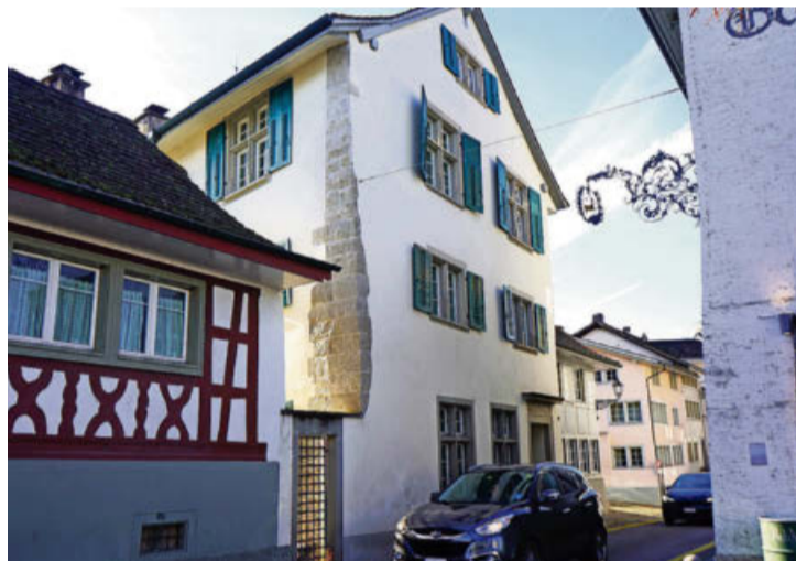
Aktuell ist auch diese Liegenschaft noch vom Durchgangsverkehr betroffen – dank isolierten Fenstern aber nur unmerklich.
