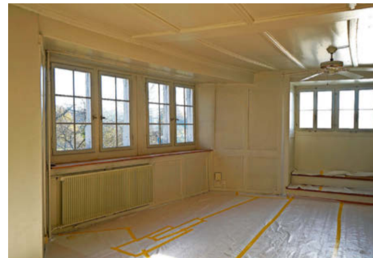
In den Altbauten entstehen einzeln bewohnbare Zimmer mit geteilten Bädern. Aktuell finden noch Bauarbeiten statt. Fotos: Marie Fredericq
